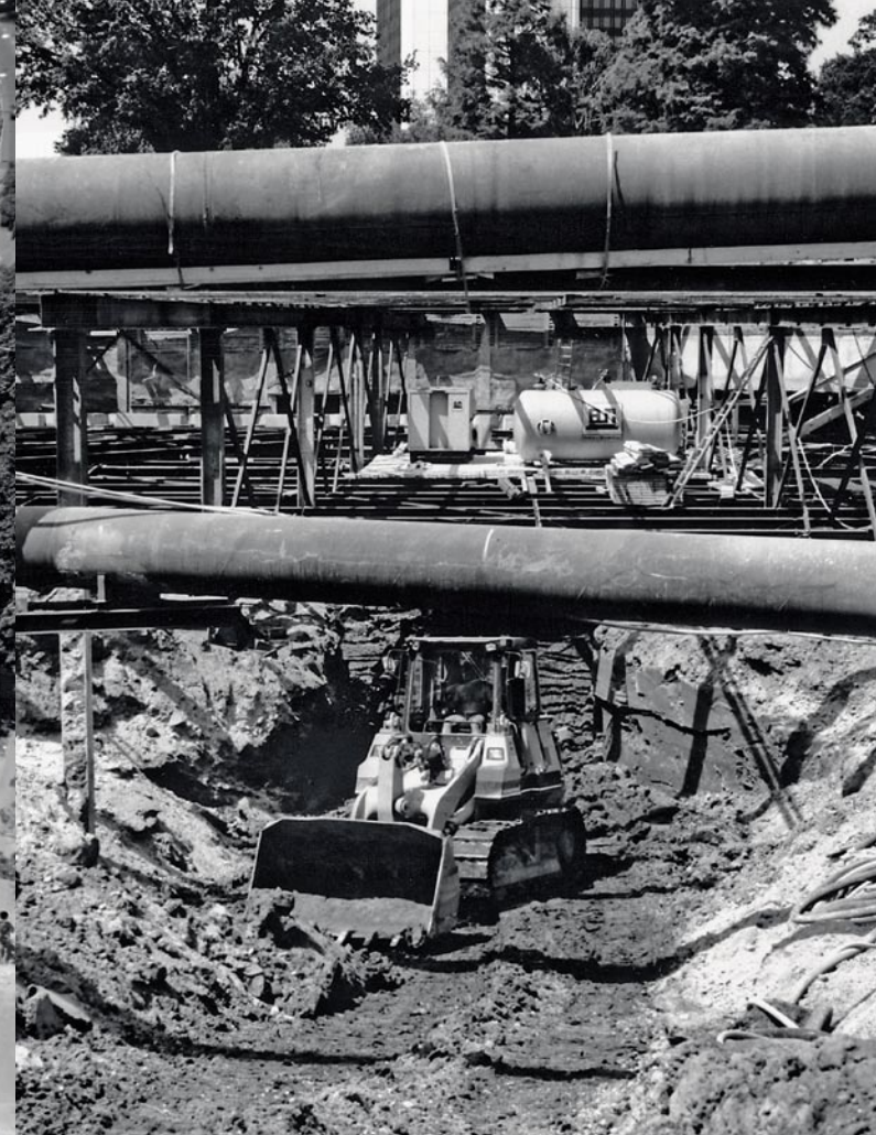
Versorgungsleitungen über der Baugrube „Festhalle/Messe“
