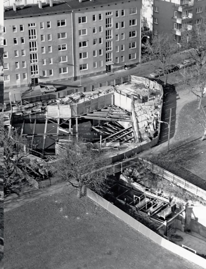
Baugrube der nordöstlichen B-Ebene der Station „Eissporthalle/Festplatz“
