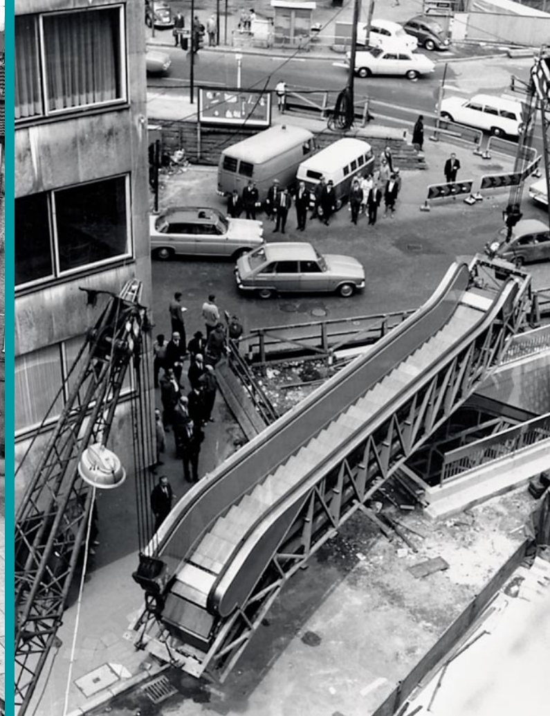
Einbau einer Rolltreppe an der Station „Theaterplatz“
