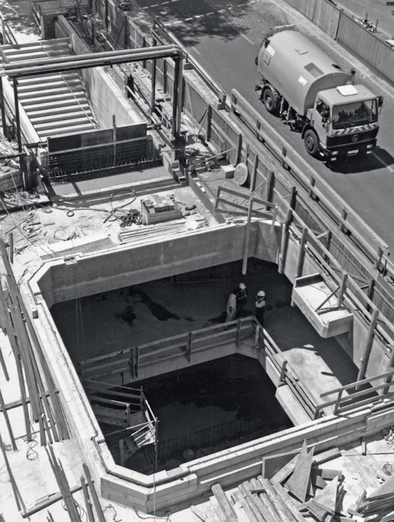
Rohbau der Station „Ostbahnhof“. Der große Lichtschacht reicht bis zur Bahnsteigebene hinunter
