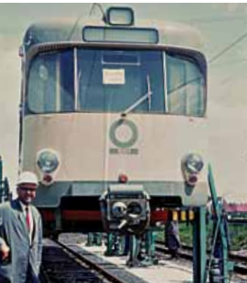
Das Abladen des ersten „U1“-Triebwagens 1001 am 20. Mai 1966 im Güterbahnhof Oberursel geschah mit Hilfe von Hebeböcken. Archiv Peter F. Linhart
