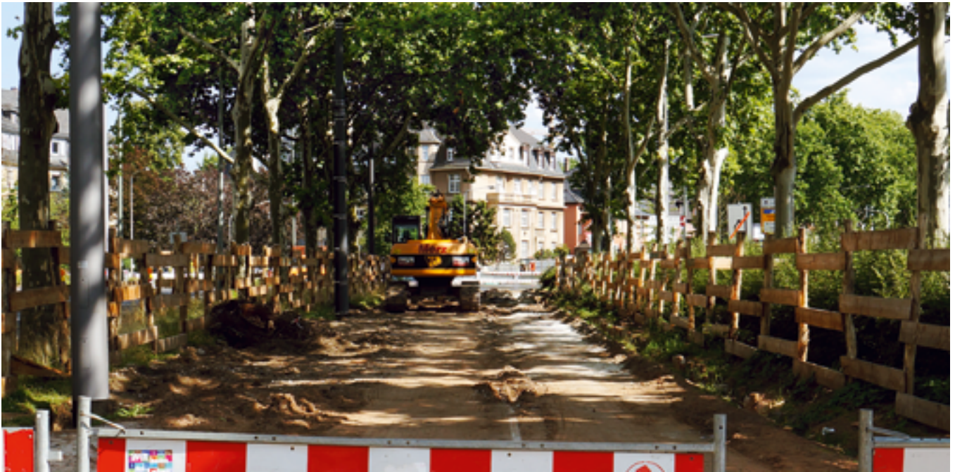
Baumschutzmaßnahmen im Baustellenbereich auf der Stresemannallee.
